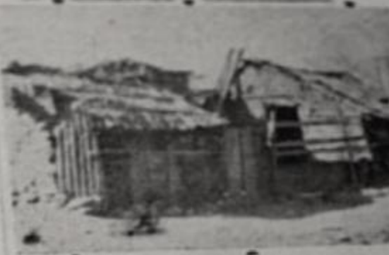
Viviendas de las poblaciones callampas ubicadas en las márgenes del Río, que ayer fueron arrasadas por las aguas de ese cauce que han aumentado considerablemente a consecuencias del violento temporal desencadenado en la región.
